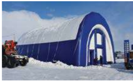
Рис. 1. Надувной ремонтный бокс для обслуживания и ремонта ТТМ в северных условиях
