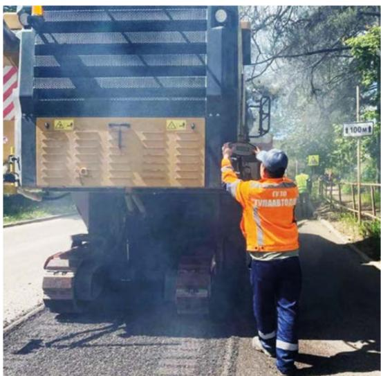
В Тульской области в рамках нацпроекта «Безопасные качественные дороги» стартовали работы в городе Алексине на улице Арматурной. Строительная техника осуществляет фрезеровку дорожного покрытия. Участок дороги будет капитально отремонтирован с использованием двух слоев асфальтобетона.
